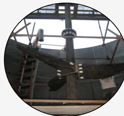
همزن پکیج فلوکولانت میدوک ۵.۵ کیلو وات ابعاد تانک: قطر ۳.۷ ارتفاع ۵ متر
